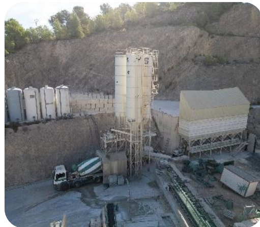
Planta hormigón Atzeneta
