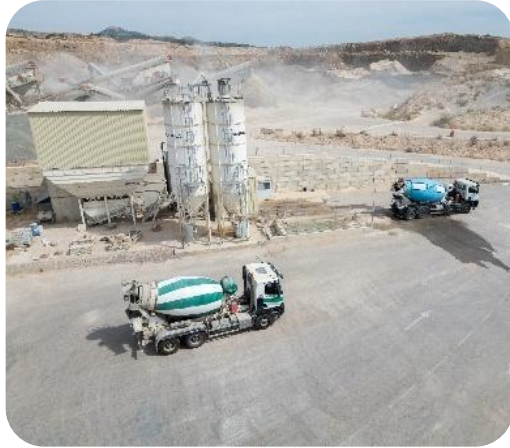
Planta hormigón Villena
