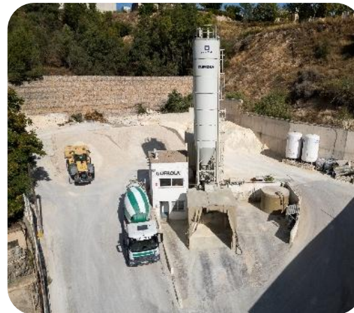
Planta hormigón Alcoy
