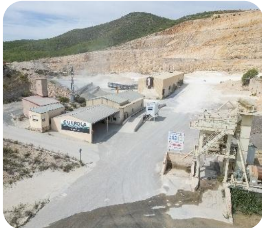
Planta asfalto Ontinyent
